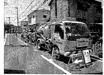
下水道管きよの清掃状況
