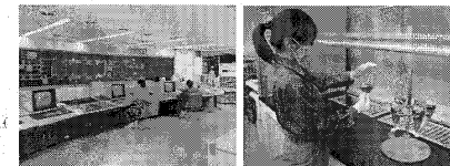
下水道サービスの安定的な提供のため、生活排水の処理や雨天時の「ポンプ」排水を24時間体制で行っています。
