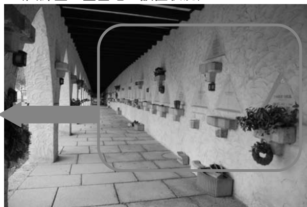
(回廊型の壁墓地の設置状況)
