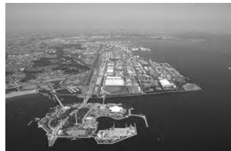
写真-4.1.6 金沢地先埋め立て
