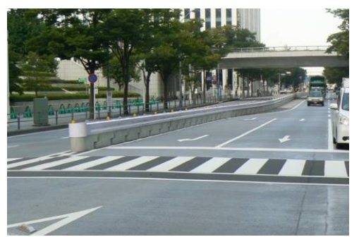
仮設中央分離帯の設置
