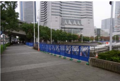
仮設フェンスの設置
