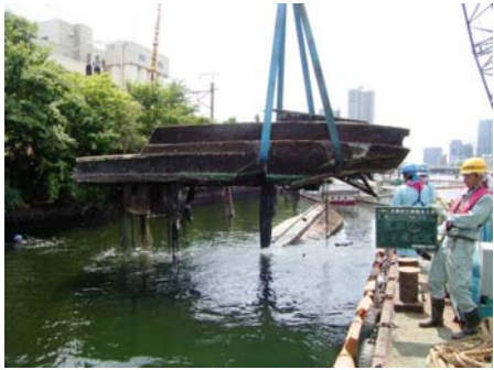
沈廃船の撤去
