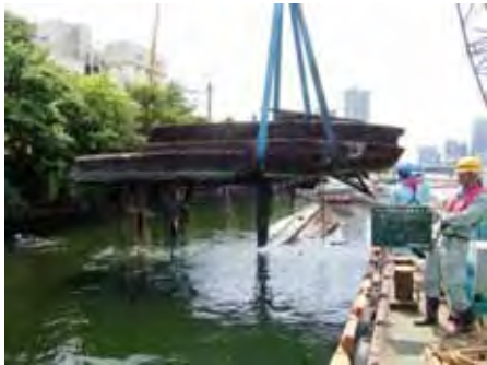
沈没船の撤去
