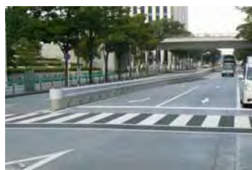
仮設中央分離帯の設置
