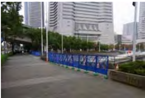
仮設フェンスの設置
