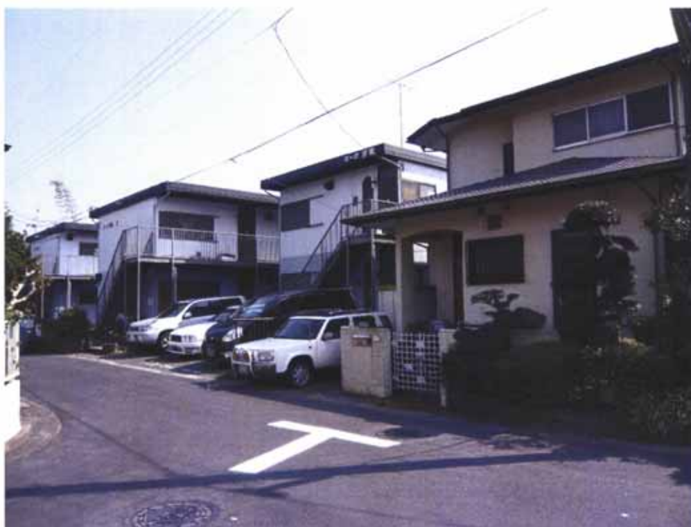
写真④ A 4地区に建ち並ぶ共同住宅
