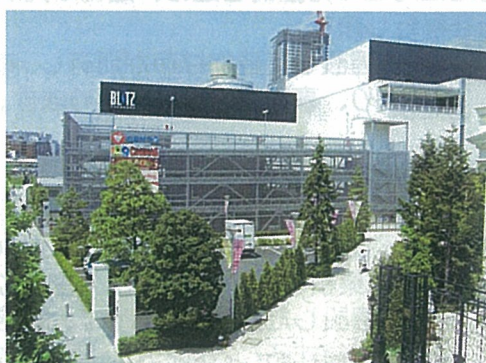
（暫定利用中の施設：GENTO YOKOHAMA）
