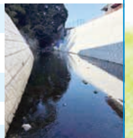
阿久和川の 河川改修の状況
