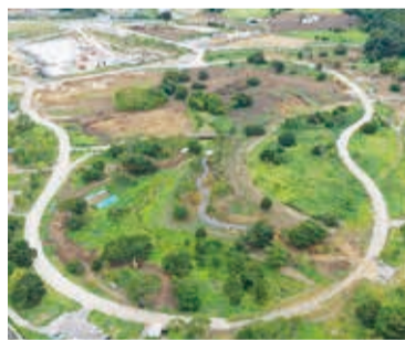
公園整備の状況(和泉川付近)
