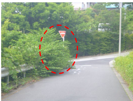
・道路にはみ出し標識を覆う雑草
