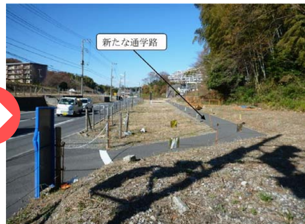
図表21 施工後の道路
