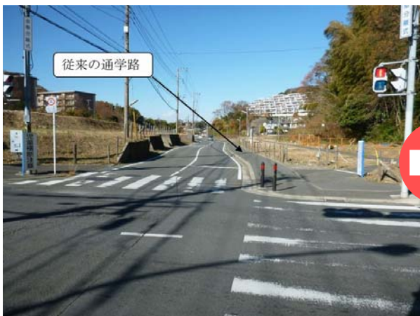
図表20 施工前の道路
