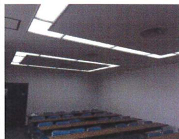
2号会議室を LED 照明へ改修
