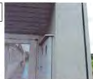
部分塗装修繕等は職員が対応
