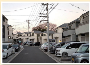
亀井町では大規模宅地造成
