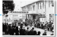
2代目西区庁舎 (昭和26年)
