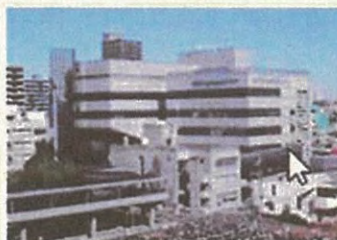
厚木市保健福祉センター (神奈川県厚木市)
