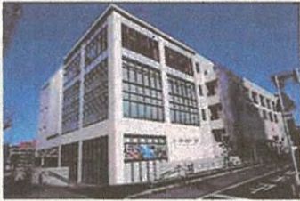
八千代市総合生涯学習プラザ (千葉県八千代市)
