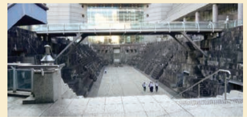
ドックヤードガーデン(旧第2号船渠)
