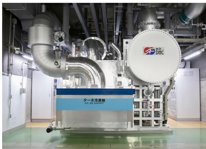
世界最大級の冷凍機。冷房に使用するエネルギーを効率良く製造
