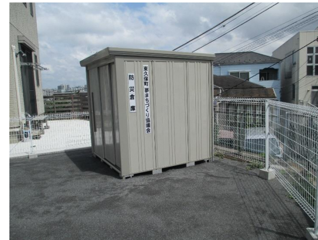
第2防災広場 防災倉庫を設置
