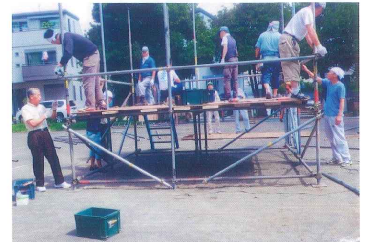
池ノ上公園にて 櫓の組み立て中
