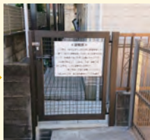
避難扉の設置
