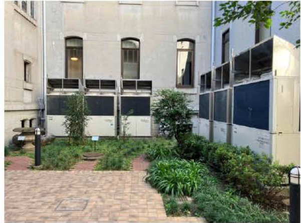
写真 3-8 中庭西側 (EV 北側から西方見る)
