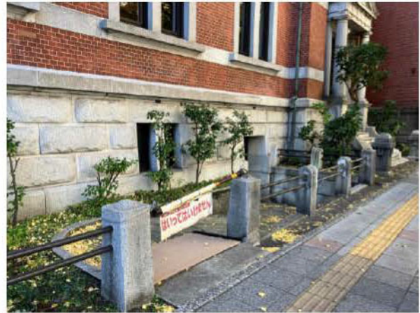
写真 3-32 東側外構 東スロープ前から北方見る
