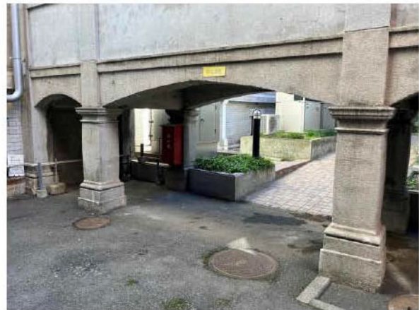
写真 3-4 渡り廊下北西から見る
