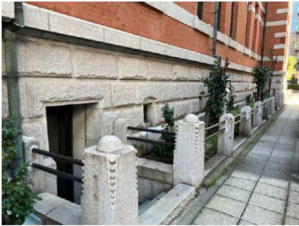
写真 3-21 西側外構 西側管理通用口から南方見る
