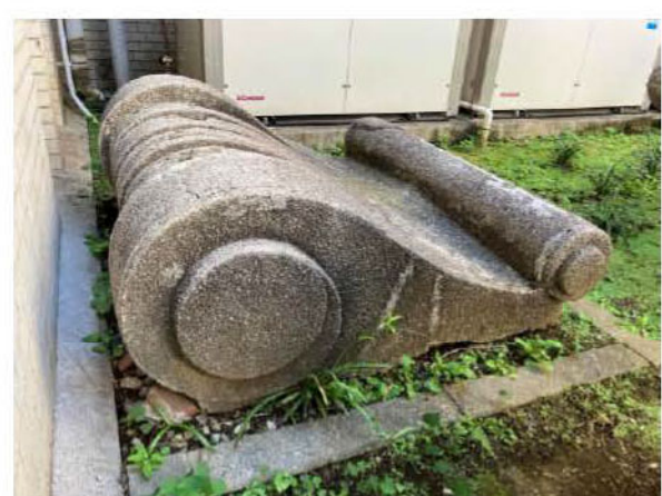
写真 3-18 中庭設置 「軒飾り」 昭和 2 年設置、平成元年撤去物
