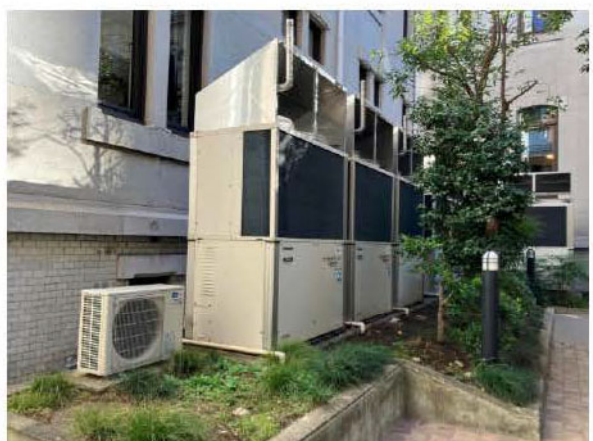
写真 3-6 中庭東側（北側から南東方見る）
