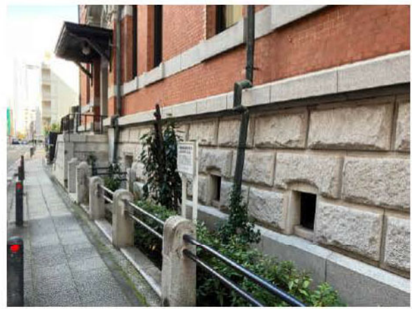
写真 3-22 西側外構 南西部から北方見る
