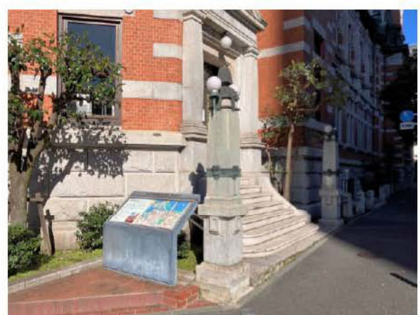
写真 3-24 南側外構 南西隅部 東方見る
