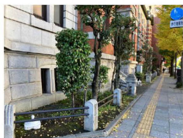
写真 3-30 東側外構 南東隅部から北方見る
