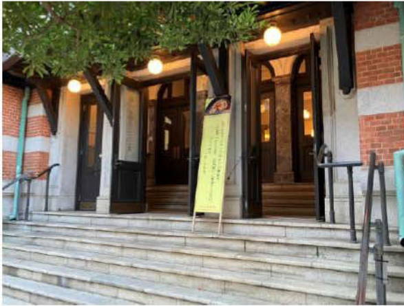
写真 3-27 南面 東正面入口 南東側から見る
