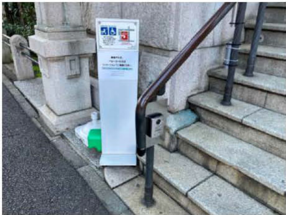
写真 3-39 東正面入口前（西） インターホンと案内板
