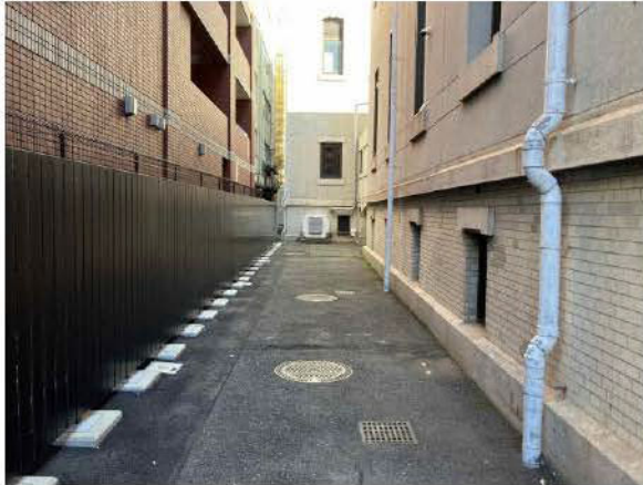
写真 3-1 北西門扉から東側見る 中庭へのアプローチ路
