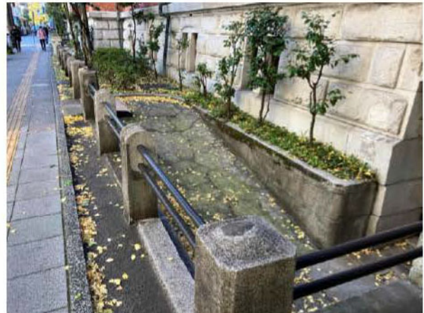
写真 3-42 東側外構 東スロープ 北側から南方見る
