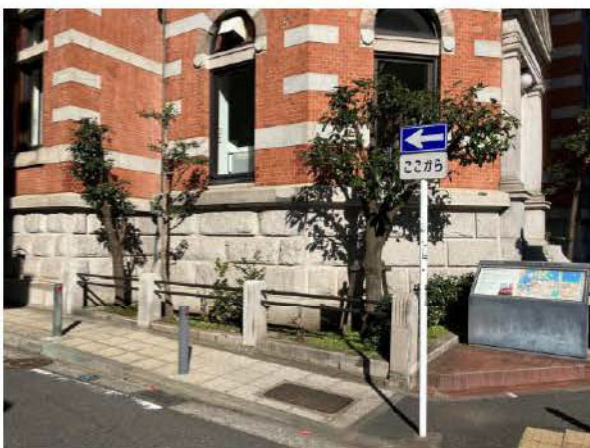
写真 3-23 西側外構 南西隅部 北東方見る
