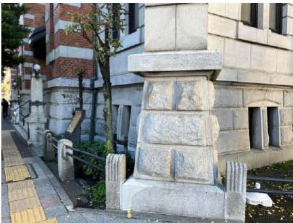
写真 3-29 南東隅外構 北西方見る
