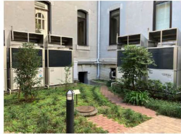
写真 3-10 中庭中央部から北西方見る
