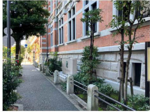
写真 3-26 南側外構 東正面入口前から西方見る
