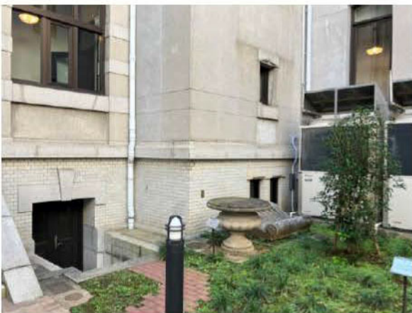
写真 3-11 中庭中央部から北東方見る南東方見る
