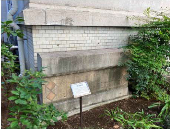
写真 3-13 中庭設置 「一階通路壁」 平成 12 年保存修理で解体したもの
