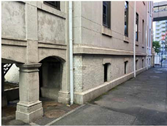
写真 3-3 渡り廊下北側から西方見る
