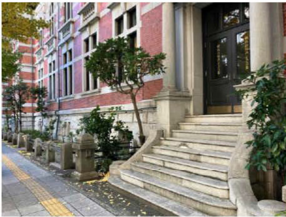
写真 3-33 東側外構 北東隅部から南方見る
