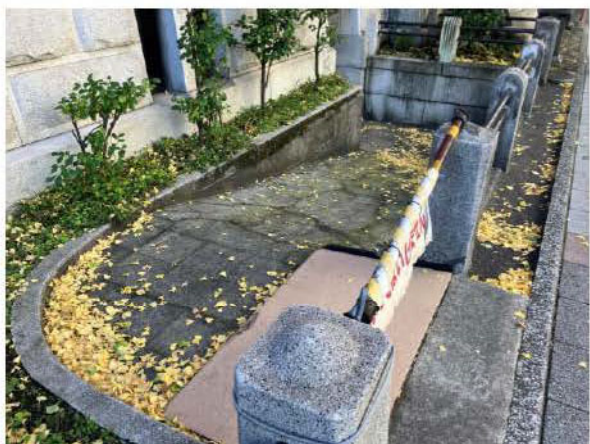
写真 3-41 東側外構 東スロープ 南側から北方見る
