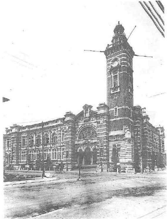
写真 1-26 震災復旧後（昭和 2 年）外観写真
