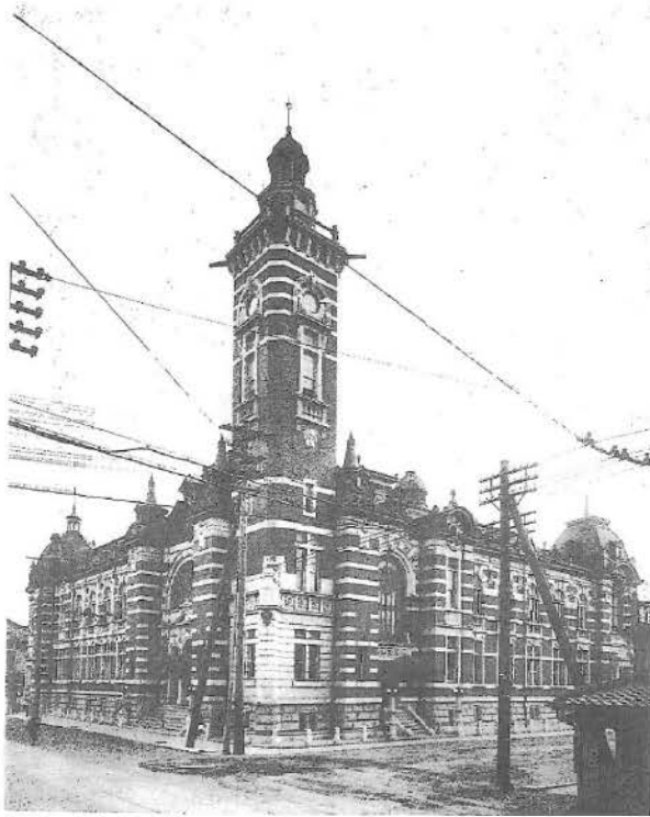
写真 1-25 創建時（大正 6 年）外観写真
