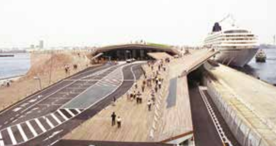
「改装された大栈橋」横浜市史資料室所蔵
