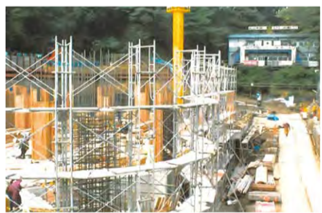
平成3年11月 南図書館建築現場
