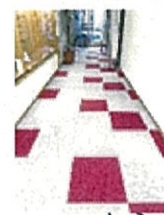
床の剥離とカーペットの張替えて雰囲気も明るくなりました
