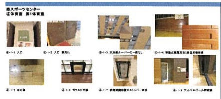
現場調査・管理状況シート
