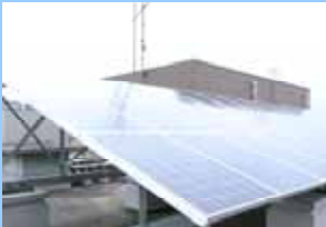
ソーラーパネル設置
