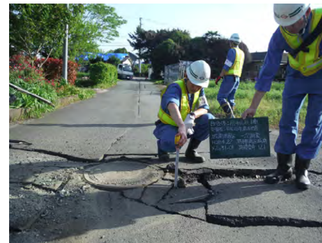
【参考】平成28年熊本地震時の管きよ調査の様子
