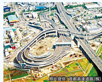
横滨港北匝道
