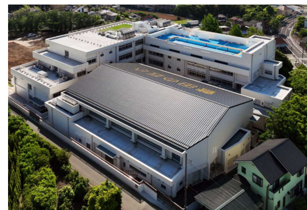
横浜市立菅田の丘小学校（令和6年4月竣工） 学校規模適正化と学校施設の建替えを併せて検討、実施 （統合建替え）
