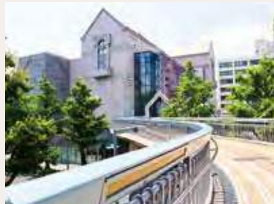
▲ポーリン橋と人形の家
