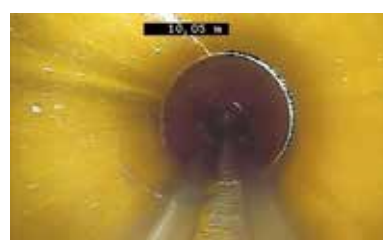
▲下水道管のそうじ・調査を行うノズルカメラ ▲カメラでみた下水道管の中
