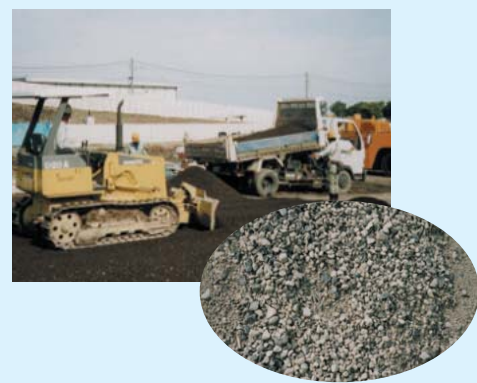
スラグを使用した試験舗装状況 Test paving using slag
