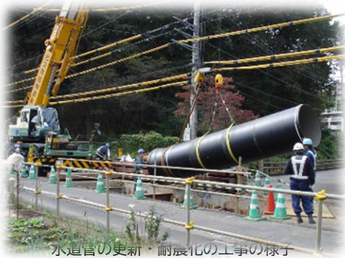
水道管の更新・耐震化の工事の様子
