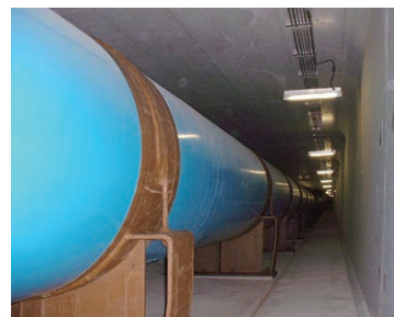
▲口径1,350mmの保土ヶ谷共同溝線
