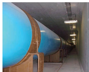
▲口径1,350mmの保土ヶ谷共同溝線
