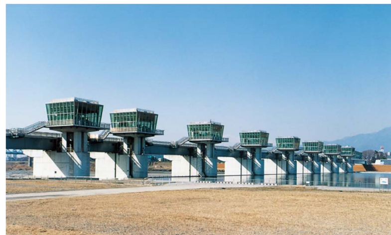
相模大ぜき：相模川の河口から約12km上流の地点にあり、原水を取水する施設
