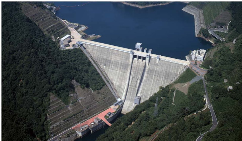
宮ヶ瀬ダム：県民に水道水を安定的に供給するために建設 平成13年度より本格稼働
