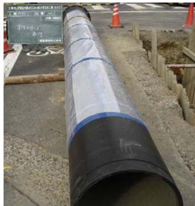
←ポリエチレンスリーブを巻いたダクタイル鋳鉄管 (局独自の想定耐用年数80年)
