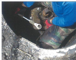
仕切弁附属設備修理工事
