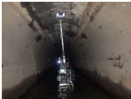
導水施設の健全度調査
