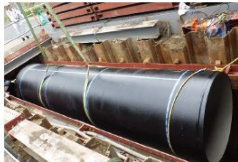
送配水本管(口径400mm以上)の更新工事
