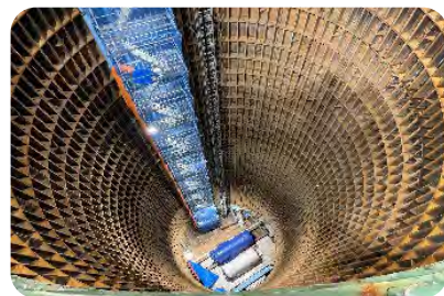
羽沢町立坑(深さ約48m)
