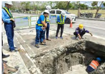
漏水修理の現場指導(フィリピン)
