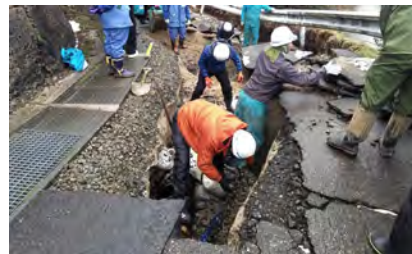
被災地での応急復旧
