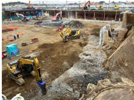
西谷浄水場再整備(1号配水池)
