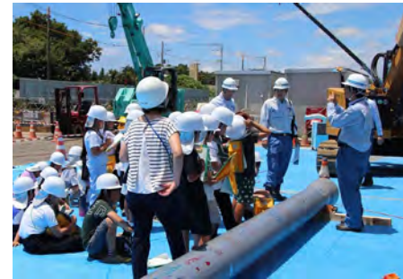
小学生向け工事見学会
