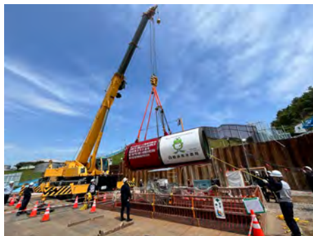
水道管更新工事(シールド工事)
