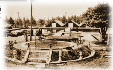
川井浄水場接合井(大正4年)
