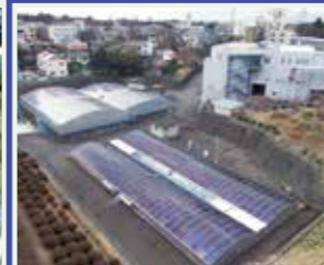
排水処理施設
