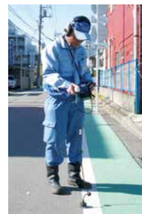
道路での漏水調査
