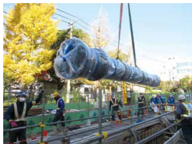
送配水管の更新工事
