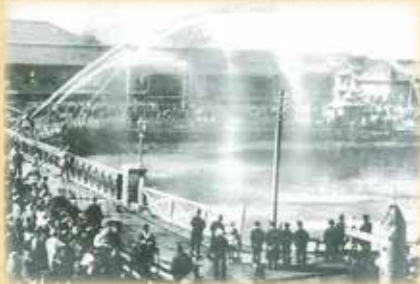
通水を記念して吉田橋(横浜市中区)で行われた水道創設当時の消火栓からの放水の様子(明治20年)
