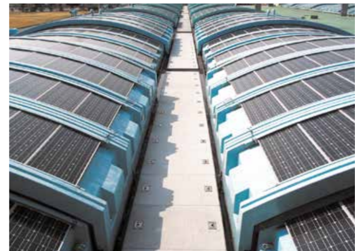
ろ過池の上部に設置された可動式太陽光発電設備(小雀浄水場)
