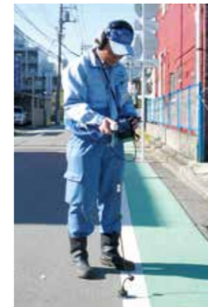
道路での漏水調査
