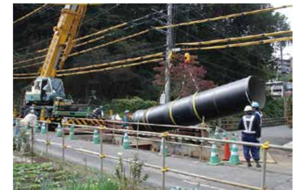
地震に強い水道管への取り替え工事
