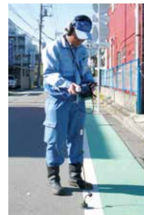
道路での漏水調査
