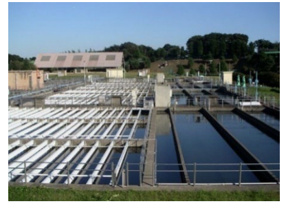
<小雀浄水場沈殿池>
