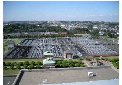
<西谷浄水場沈殿池>
