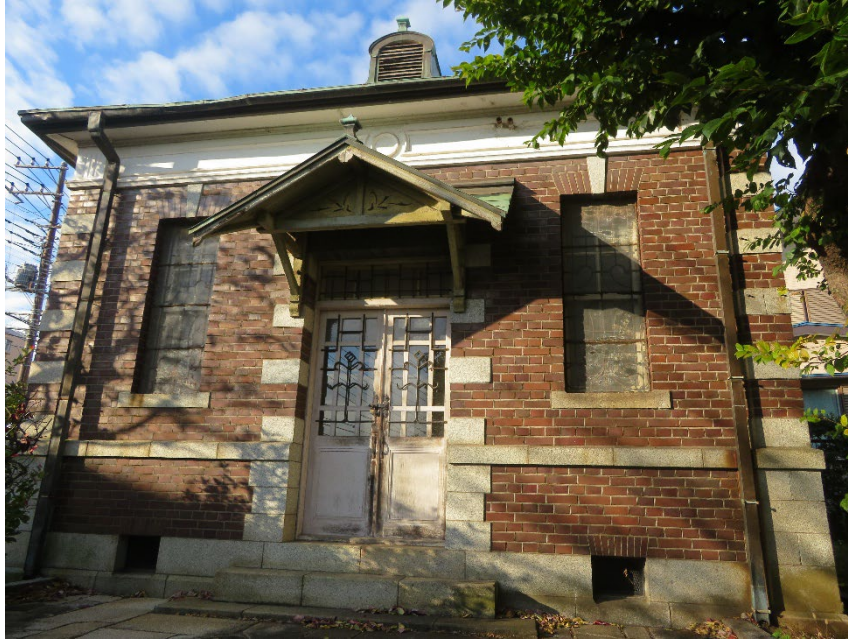
川島町旧配水計量器室上屋(登録有形文化財)
