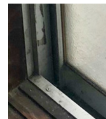
カバー工法施工前
