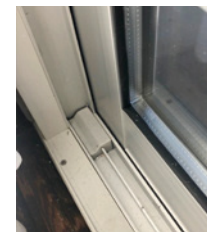
カバー工法施工後
