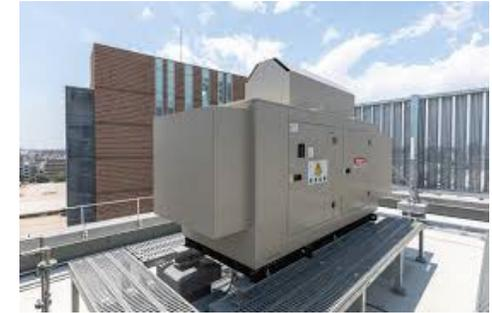
マンション屋上に設置された緊急用自家発電設備
